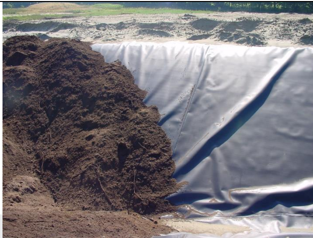
Foto: Folie belasten wanneer het niet strak ligt (o.a. uitzetting in de zon).
