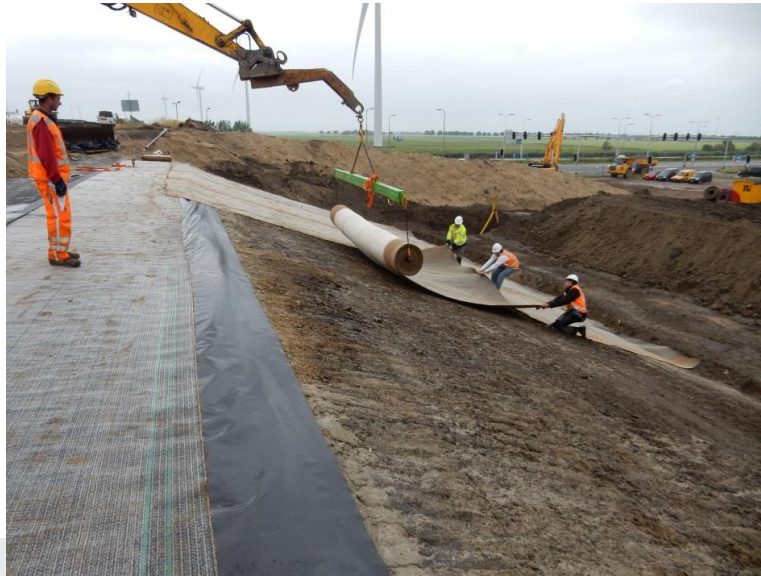
Foto: Toepassing bentonietmat.
